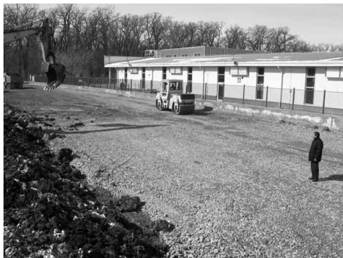
Zona de extindere a fabricii Eybl Textile S.R.L. (noua hală de încărcare).
